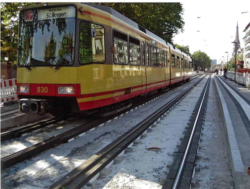
Bild 1. Fertiggestellte Fahrbahn mit Kunststofffasern am Gottesauer Platz.
