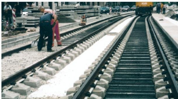
**GRÜNES LICHT FÜR DIE BAHN** Sowohl ATD-G als auch RHEDA CITY-G können mit konventionellen Straßen- und Gleisbaugeräten verlegt werden. Wenige Arbeitsschritte bei der Verlegung ermöglichen eine schnelle Bauausführung.
