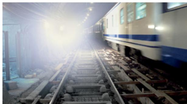
**RHEDA MRT: HUNDERT PROZENT LEISTUNG** Der „große Bruder“ RHEDA 2000® aus dem Hochgeschwindigkeitsbereich stand Pate bei der Entwicklung dieser leichteren Variante für U- und S-Bahnen.
