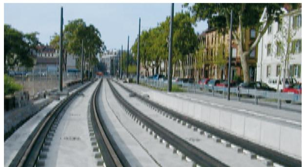
**IN DER RUHE LIEGT DIE KRAFT** Kammerelemente verhindern das Heranwachsen der Vegetation an die Schiene. Gleichzeitig wird die Luftschallemission reduziert.
