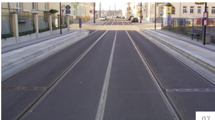
01 Auslegen der Zweiblockschwellen und Aufsetzen der Schienen 02 Detail Einbauten und Höhenregulierung 03 Auf dem Planum ausgelegter und komplett in Richtung und Höhe regulierter Gleisrost 04 Anbringen der Schwellenfachzwischenlagen 05 Betonieren des Gleisrostes 06 Einbau von Kammerelementen in die Schienenkammern 07 Deckenschluss, z. B. mit Asphalt
