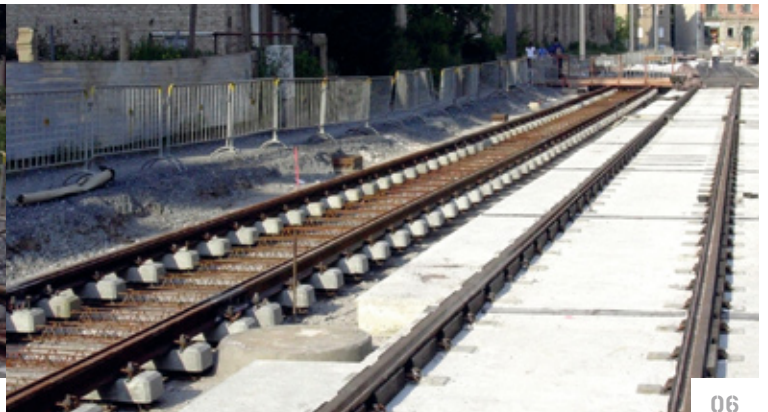
01 Auslegen der Zweiblockschwellen und Aufsetzen der Schienen 02 Detail Einbauten und Höhenregulierung 03 Auf dem Planum ausgelegter und komplett in Richtung und Höhe regulierter Gleisrost 04 Anbringen der Schwellenfachzwischenlagen 05 Betonieren des Gleisrostes 06 Einbau von Kammerelementen in die Schienenkammern 07 Deckenschluss, z. B. mit Asphalt
