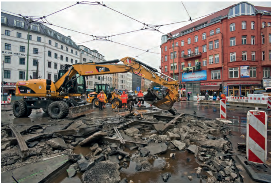
Abb. 4: Rückbau des alten Bestandgleises
