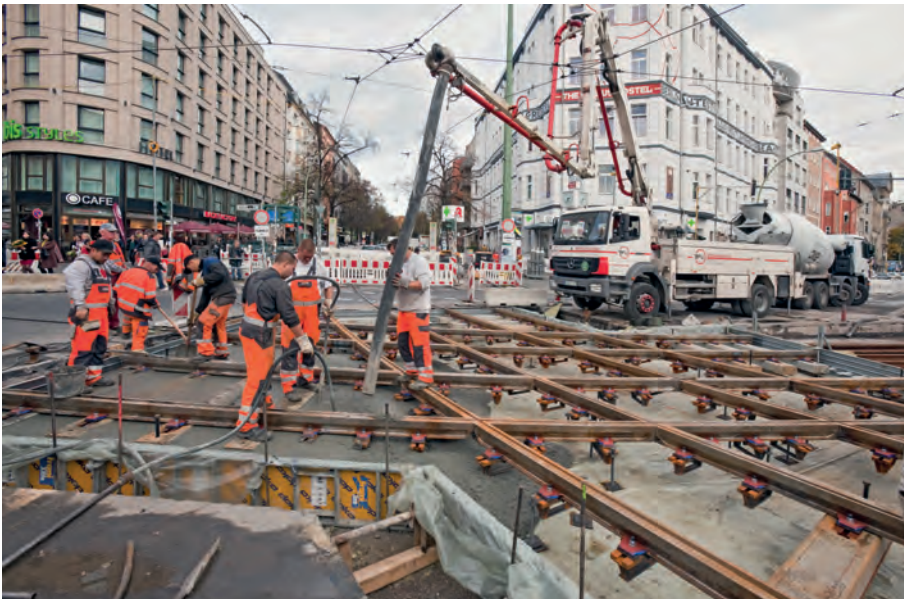
Abb. 8: Betonage der Fahrbahnplatte
