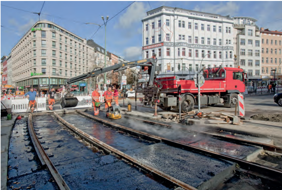
Abb. 9: Herstellen der Asphaltdeckschicht
