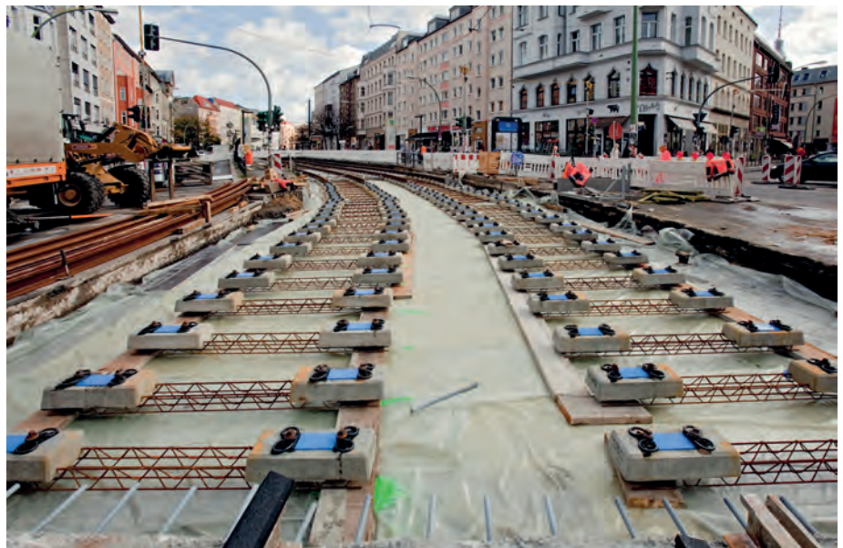
Abb. 6: Aufbau der Rheda-Gleisjochs
