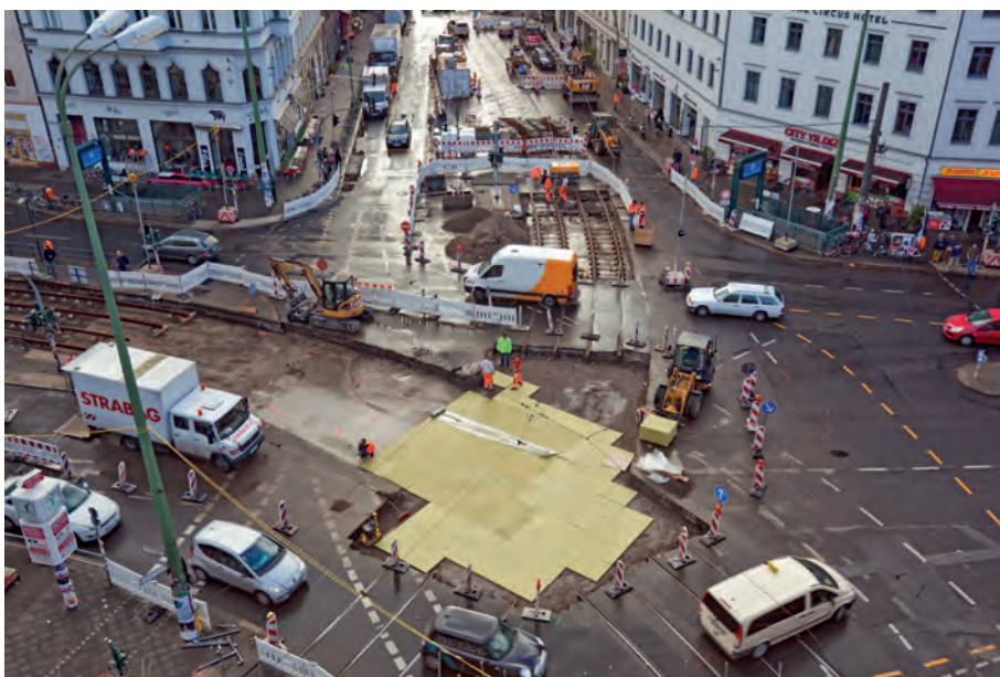
Abb. 5: Verlegung der RockXolid-Matten
