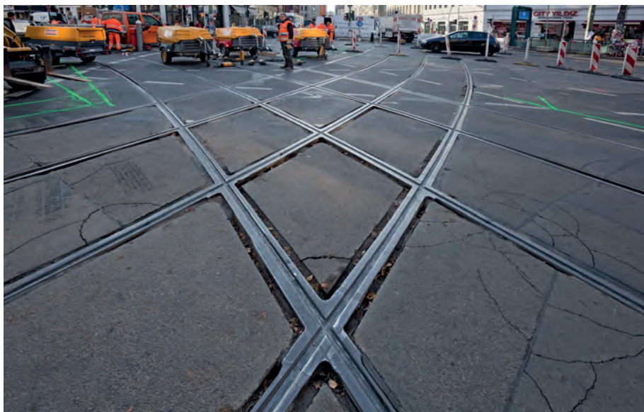
Abb. 2: Ausgangssituation Aufnahme Bestandsgeis vor der Erneuerung
