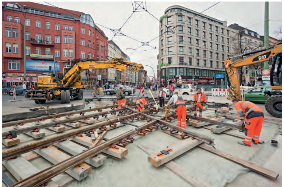
Abb. 7: Einbau der Easy-Kreuzung auf Rheda-Weichenschiwellen
