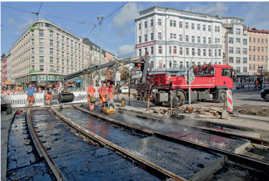
Abb. 9: Herstellen der Asphaltdeckschicht
