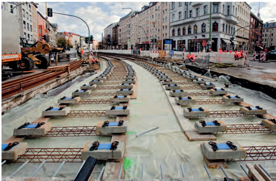
Abb. 6: Aufbau der Rheda-Gleisjoch
