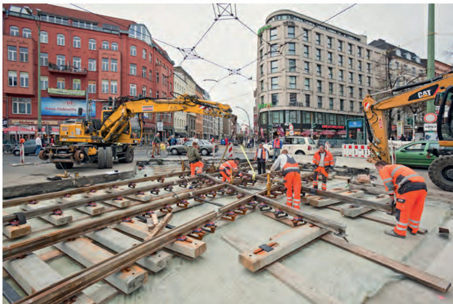
Abb. 7: Einbau der Easy-Kreuzung auf Rheda-Weichenschwellen
