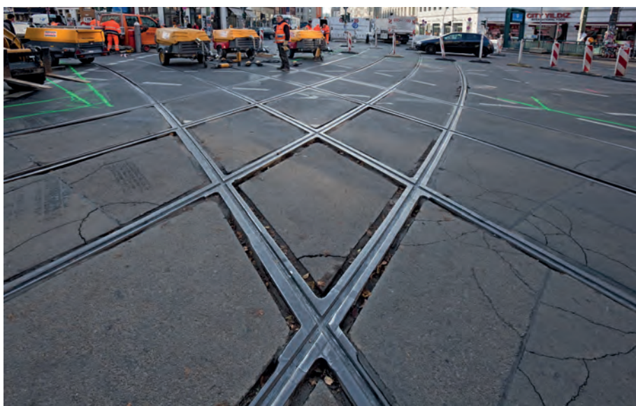
Abb. 2: Ausgangssituation Aufnahme Bestandsgleis vor der Erneuerung
