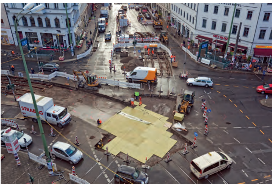
Abb. 5: Verlegung der RockXolid-Matten
