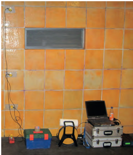
Abb. 11: Schwingungsmessung mit Geofonen im Bahnhofsbereich der U-Bahn
