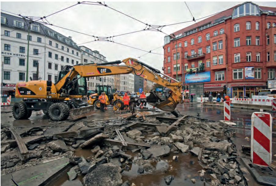
Abb. 4: Rückbau des alten Bestandsgleises
