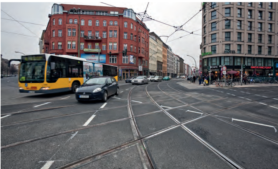
Abb. 10: Fertigstellung der Gleisanlage und Eröffnung für den Verkehr
