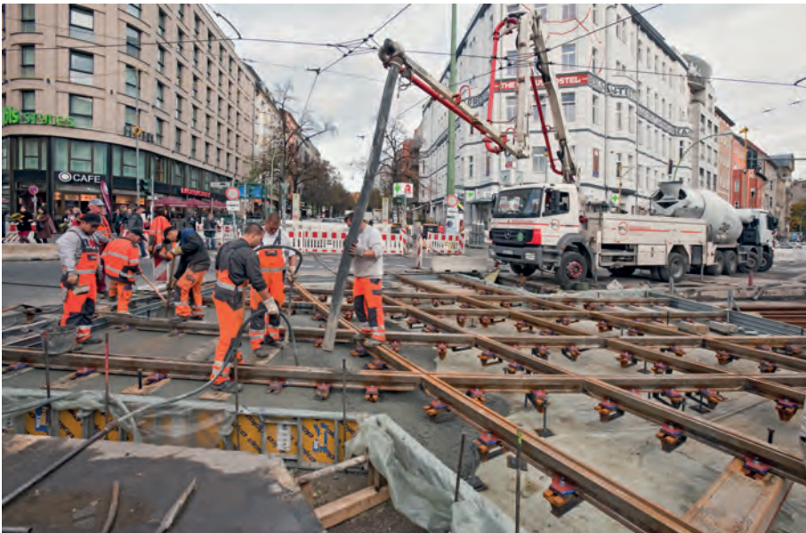
Abb. 8: Betonage der Fahrbahnplatte
