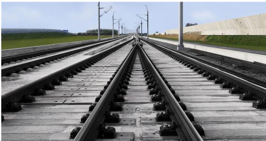
**Bildunterschrift:** Hochgeschwindigkeits-Weichenschwellen vom Typ RHEDA 2000® (Foto: PCM RAIL.ONE AG).
